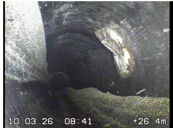
10, 00:04:25, 26.40m Abplatzung, Ursache nicht eindeutig feststellbar bei 1 Uhr
