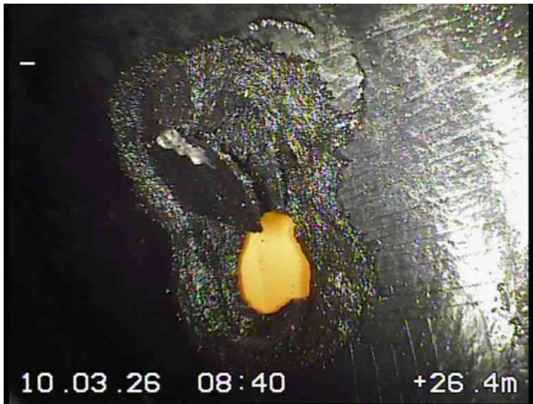
9, 00:04:25, 26.40m Abplatzung, Ursache nicht eindeutig feststellbar bei 1 Uhr
