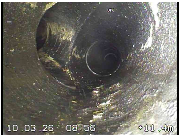
3, 00:01:40, 11.40m Anschluss mit Formstück, offen bei 9 Uhr
