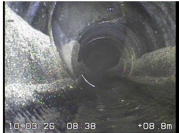
2, 00:01:37, 8.80m Anschluss mit Formstück, offen bei 11 Uhr
