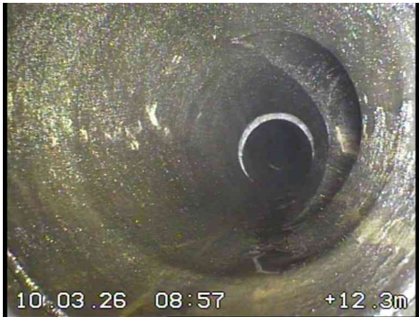
5, 00:02:17, 12.30m Anschluss mit Formstück, offen bei 3 Uhr
