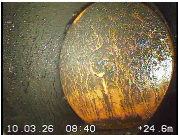
7, 00:03:57, 24.60m Anschluss mit Formstück, verschlossen bei 3 Uhr
