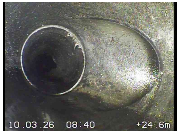
8, 00:03:57, 24.60m Anschluss mit Formstück, verschlossen bei 3 Uhr
