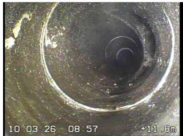
4, 00:02:00, 11.80m Anschluss mit Formstück, offen bei 3 Uhr
