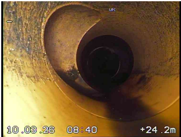
5, 00:03:40, 24.20m Anschluss mit Formstück, offen bei 9 Uhr
