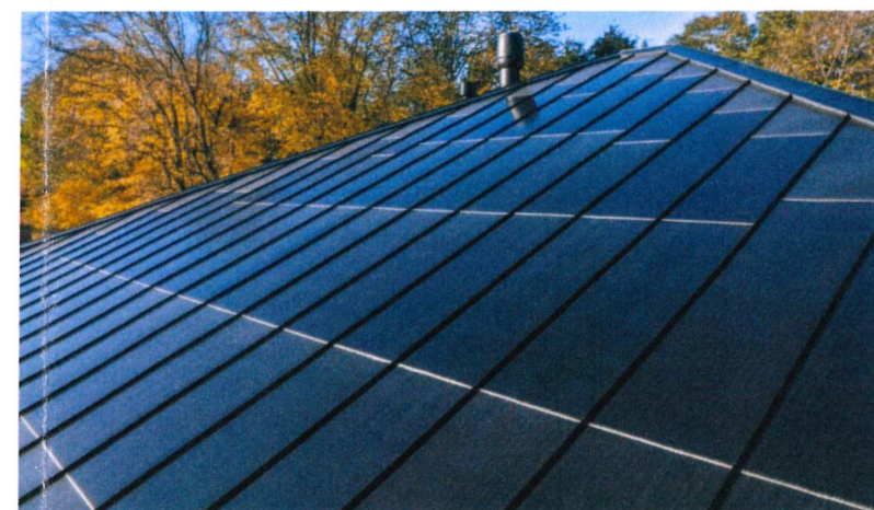
Roofit Indach Solaranlage
