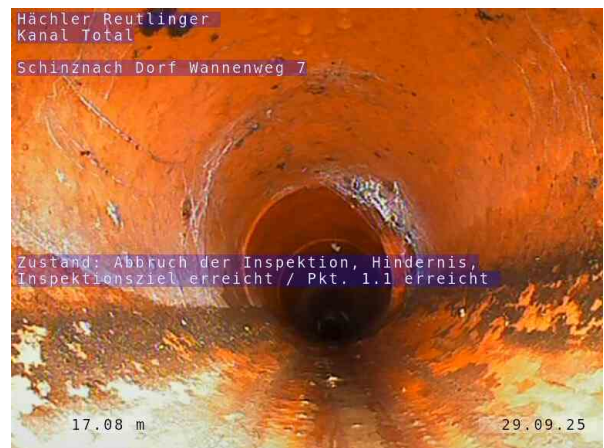
12, 00:04:56, 17.08m Abbruch der Inspektion, Hindernis, Inspektionsziel erreicht / Pkt. 1.1 erreicht
