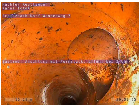
11, 00:04:32, 16.28m Anschluss mit Formstück, offen, bei 3 Uhr
