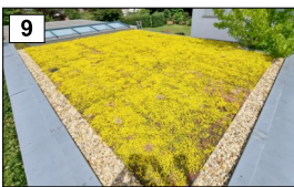
Extensive Dachbegrünung auf Garage
