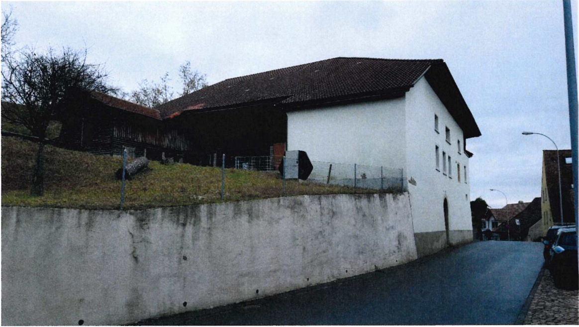
Süd- und Westfassade von Hohestrasse
