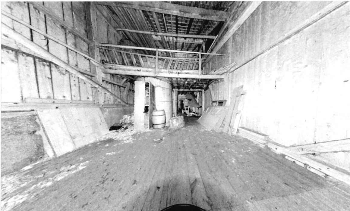
Innenraum Scheune Niveau 1, Blickrichtung Osten
