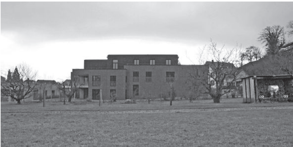
Rückseite des Wohnblocks von der SBB-Baustrasse in Richtung Dorf gesehen.
