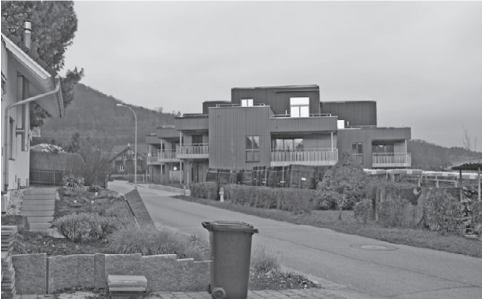
Sicht von der Bözeneggstrasse in Richtung Bözenegg.
