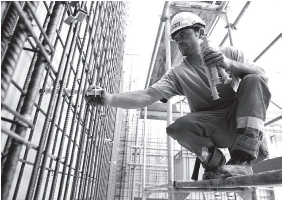
Maurer Fernandez Treitos Joào beim Versetzen von Distanzhaltern.
