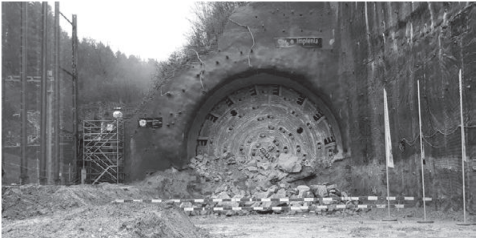
Durchschlag der Tunnelbohrmaschine in den Voreinschnitt Effingen am 29.11.2017.
