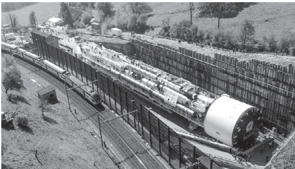
Fertig montierte Tunnelbohrmaschine am Tag der offenen Baustelle am 29.04.2017.
