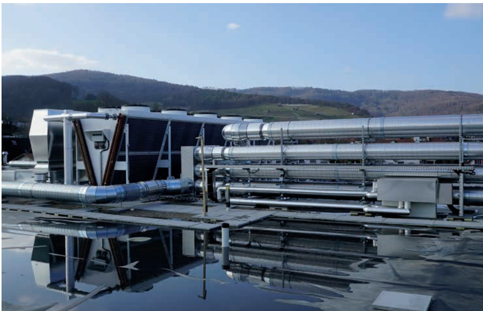
Installation auf dem Dach des Neubaus Constri AG, Schinznach-Dorf, 2016.
