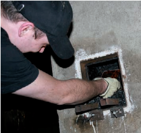
Während des Ausbrennens wird der Querschnitt des Kamins mit dem Spiegel laufend kontrolliert.
