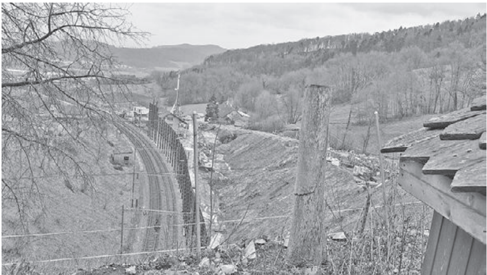
Die SBB-Baustelle in der Bözenegg, Schinznach-Dorf.
