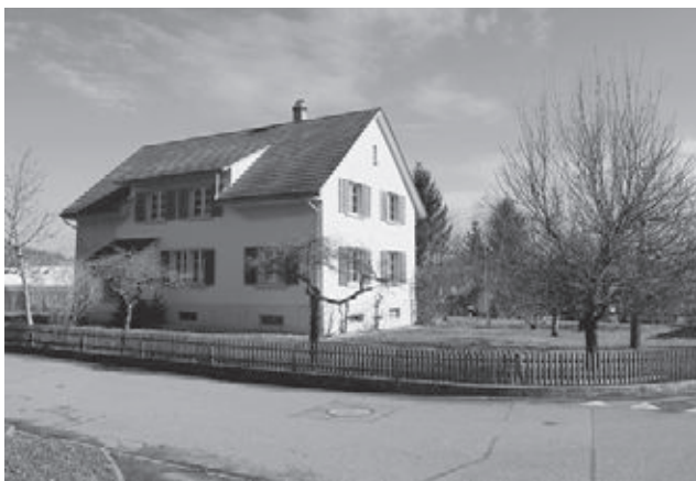
Haus Schulstrasse 13, Schinznach-Dorf.
