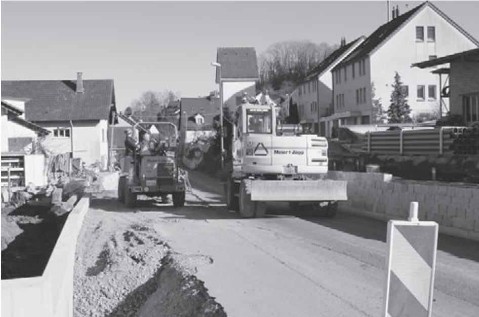
Die aufwändige, aber gründliche Sanierung der Dorfstrasse in Oberflachs.
