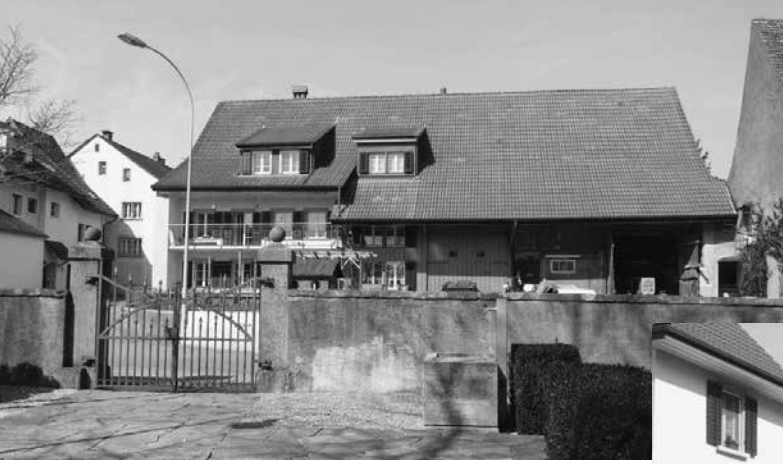
Unterdorfstrasse 7: Hof mit Doppelscheune und rückseitigem Innenhof mit Steinspicher
