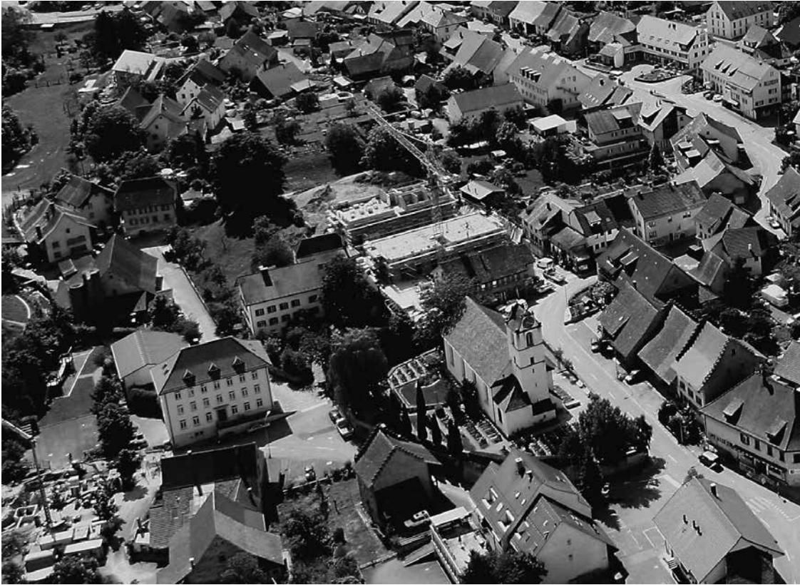
Der alte Kern von Schinznach-Dorf mit Kirchenbezirk und dem neuen Doktorhausareal, die Reihenhöfe an der Unterdorf- und Oberdorfstrasse, im Vordergrund das alte Schulhaus und dahinter das Häuserensemble um die Mittlere Mühle.
