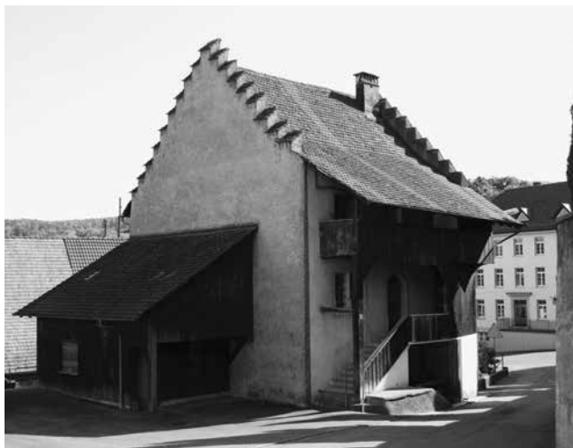
Haus Gäbigasse 3 mit Treppengiebeln.
