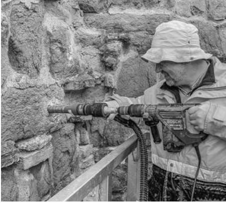
Der Firmeninhaber Dr. Philipp Rück bei einer Kernbohrung an einer historischen Mauer in Genf.
