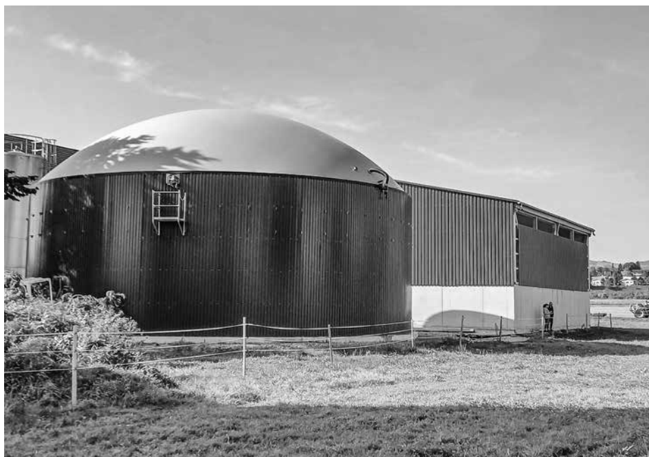
Die neue Biogasanlage von der Hauptstrasse her gesehen mit dem runden Gärdom und daneben dem Lagerraum. Darin werden die der Gülle beizumischenden Zusatzstoffe gelagert.
