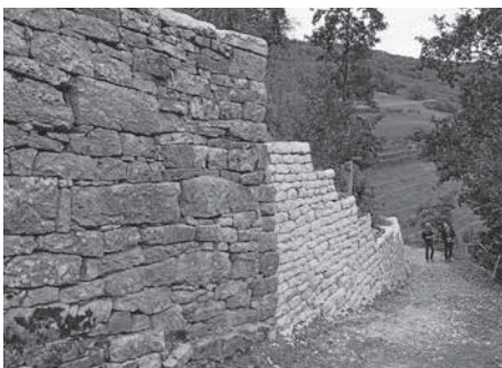
Neu und Alt nebeneinander: Bruchsteinmauerwerk Schloss Kasteln.
