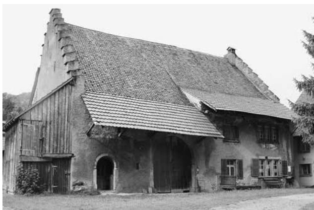
Ehemaliges Zehntenhaus (Haus Nr. 85) erbaut 1688/90, mit älteren Bauteilen
