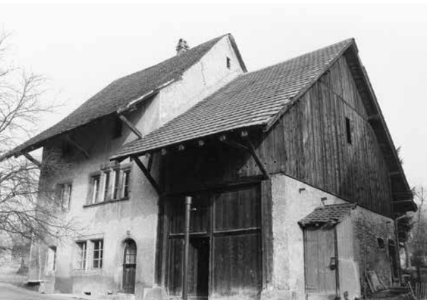
Köpflihaus in Villnachern (Haus Nr. 58) 1980 demontiert und abtransportiert
