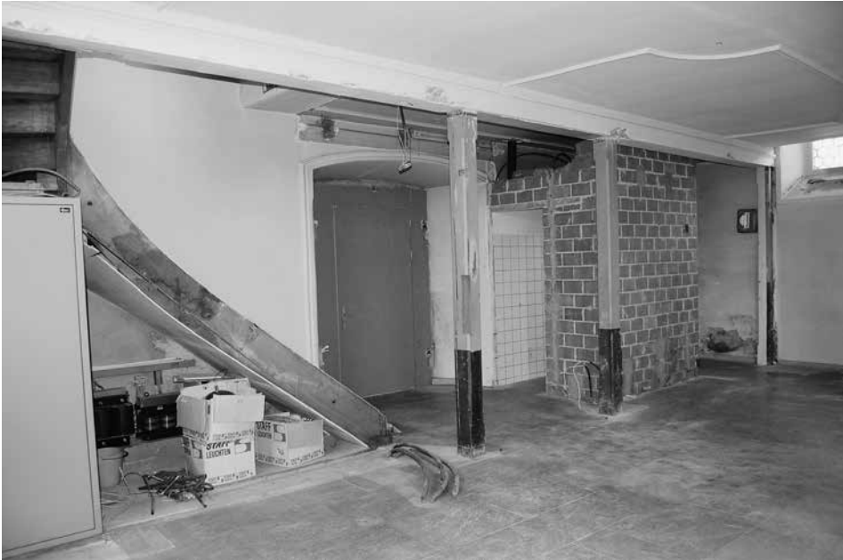
Abbruch der Einbauten unter der Empore
