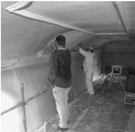
Ablaugearbeiten an der Kirchendecke
