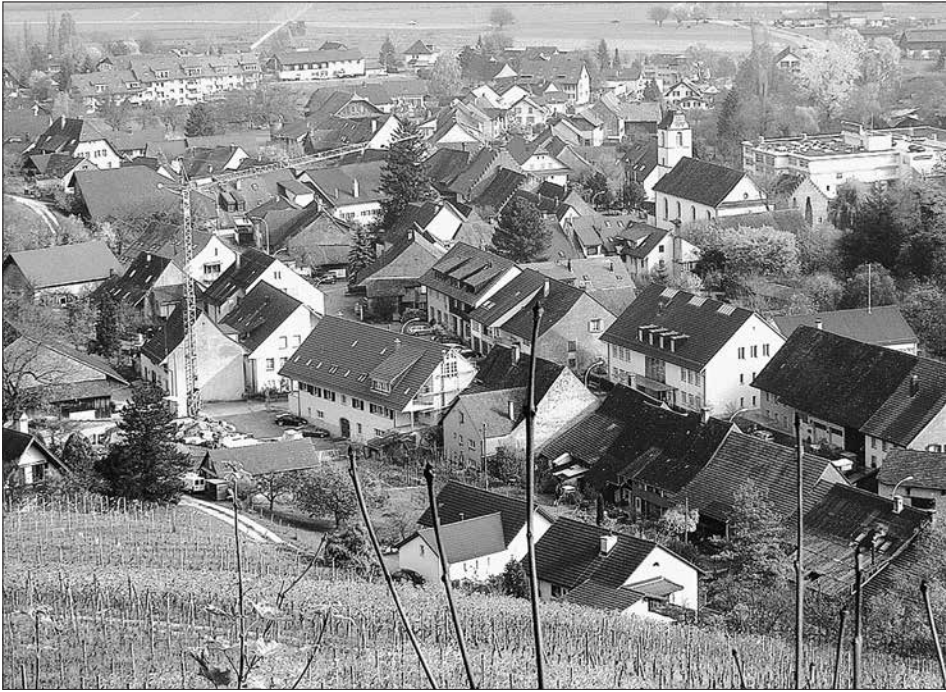
Der neue Kubus steht in gerader Linie zur Häuserzeile der Oberdorfstrasse
