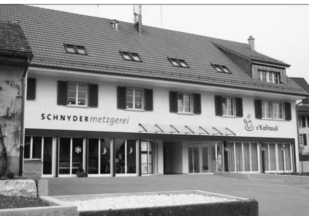
Das neue Gewerbehaus im Dorfzentrum
