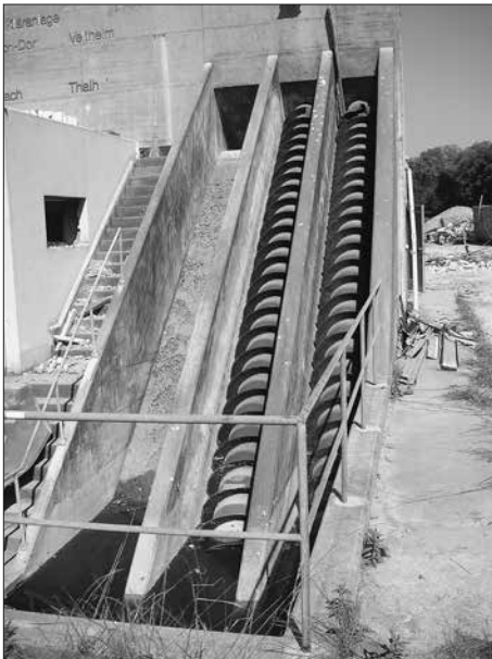
Das Schneckenpumpwerk
