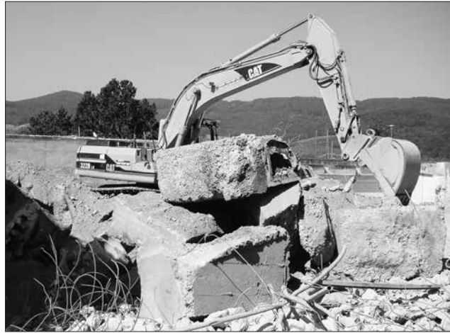
Ein Abbruch besonderer Art
