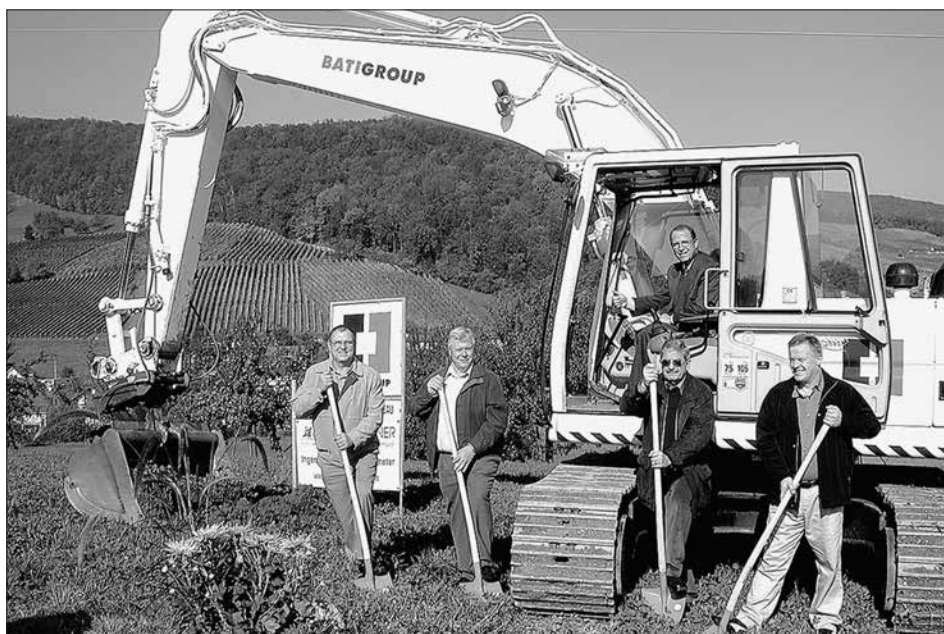
Spatenstich am gemeinsamen Veloweg der vier Gemeinden im Schenkenbergertal
