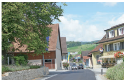
Aufgeräumt: die sanierte Hauptstrasse im Ortskern Oberflachs.
